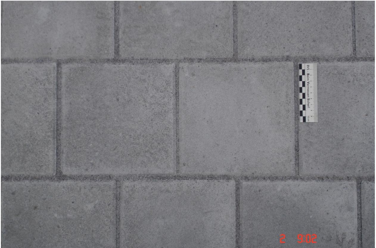
Bild 1: Pflastersystem „Verschiebesicherer 20 x 20 x 8“
